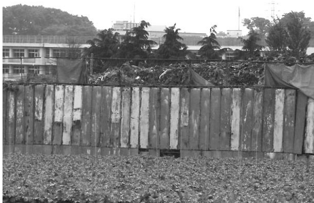
柳瀬中学校脇にある栄真建設のごみ山
